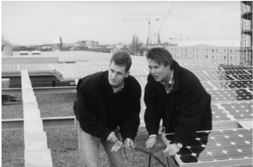
Über den Dächern von Berlin: André Dilger (links) und Andreas Königstein (rechts) installieren Fühler, welche die Temperatur an den Solarzellen messen. Foto: FHG/Thomas Nierhoff
