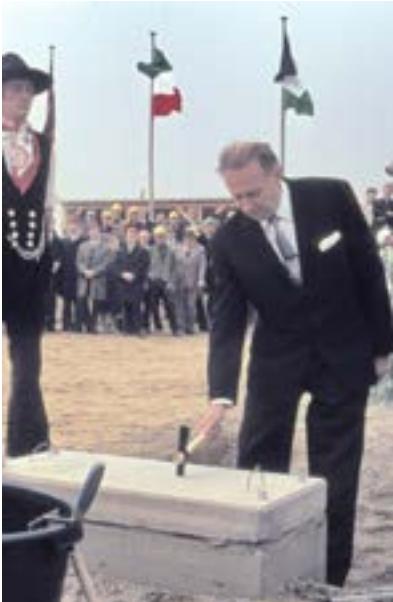
Am elften Oktober 1967 legte der damalige Ingenieurschulleiter Erich Müller den Grundstein zum Gebäude Neidenburger Straße der zu diesem Zeitpunkt bereits fünf Jahre alten staatlichen Ingenieurschule in Gelsenkirchen-Buer. Damals wurde noch die Erhebung der Ingenieurschule zur Ingenieurakademie diskutiert. Stattdessen entstand 1971 die Fachhochschule. Foto: Benning
