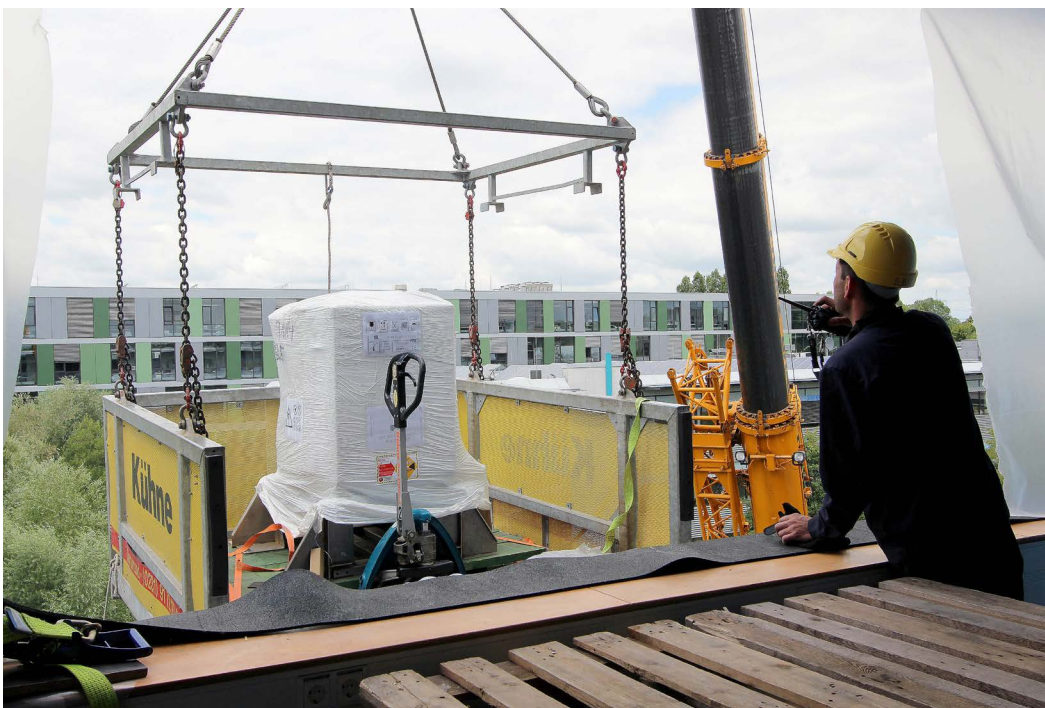
Damit der neue tonnenschwere Magnetresonanztomograf der Abteilung „Physikalische Technik“ ins Gebäude A5 der Westfälischen Hochschule gelangen konnte, musste ein Fenster ausgebaut werden. Foto: WH/BL
