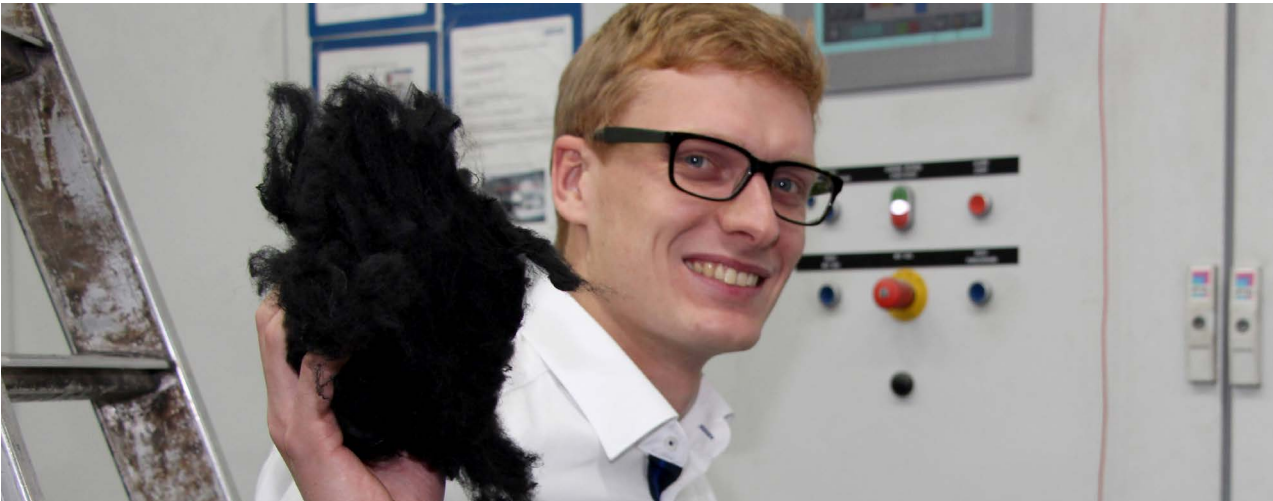
Master-Absolvent Christian Schneider hat bei der Firma Borgers in Bocholt den Energieverbrauch in der Produktionskette und den Einsatz von Energiedaten-Managementsoftware untersucht, um Einsparpotenziale zu nutzen. Hier ist er gerade vor dem Energieschaltschrank bei den Ballenauflösemaschinen. Borgers produziert aus natürlichen und synthetischen Grundstoffen textile Automobilzubehörteile wie Hutablagen oder Radkastenauskleidungen. Foto: WH/BL
