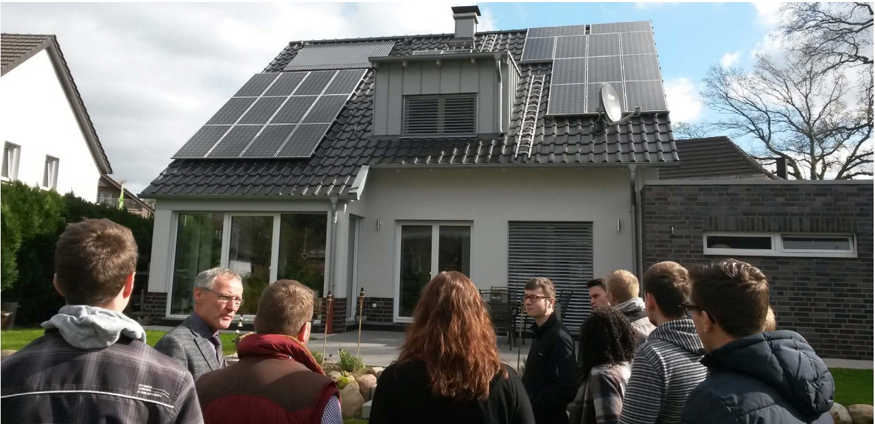
Passiv ringsum, aktiv auf dem Dach: Gute Isolierung und Zuluftregelung sorgen im Privathaus von Antonius Kappe (2.v.l.) für Wärme, Solarthermie und Photovoltaik auf dem Dach für warmes Wasser und Strom. Die Elektrotechnik-Studierenden staunten. Foto: WH/Rüter
